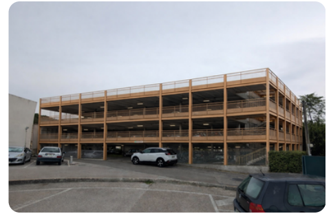
Réalisation d'un parking dit "en silo" sur le site de l'ancienne fourrière (photo démonstrative réalisée par IA)
